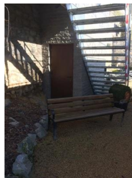
Couloir espace protégé sous l'escalier
